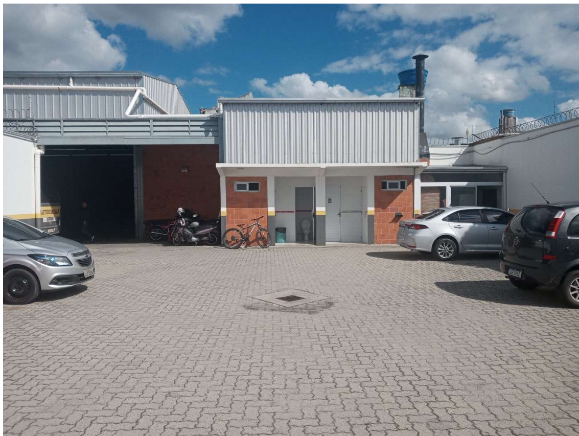
Foto 04 – Sanitários e Pátio Interno.
